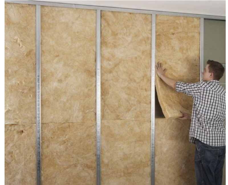
Dämmung der Innenwände - Mineralwolle
